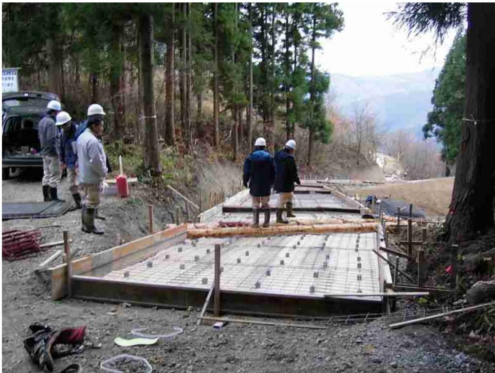
県行造林地内の路網整備事業実施箇所の視察状況
