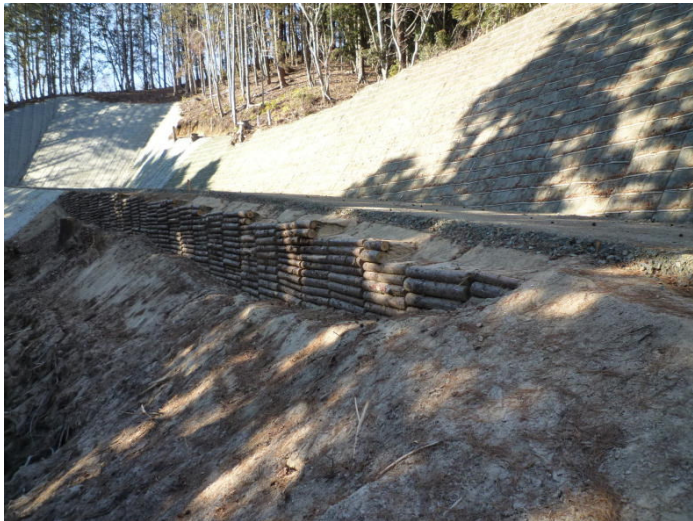
○間伐材利用 鋼製L型擁壁
