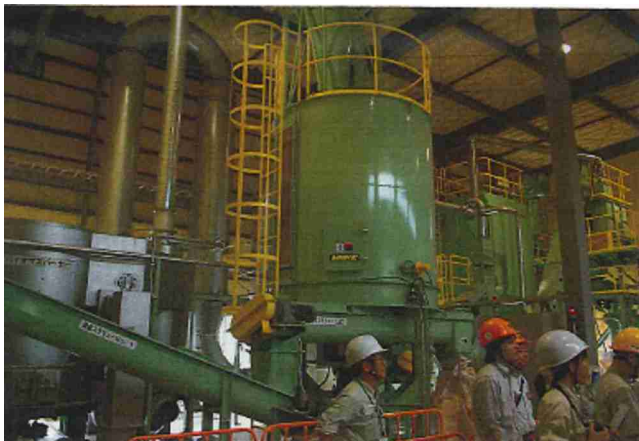
柏崎市 ペレット製造施設
