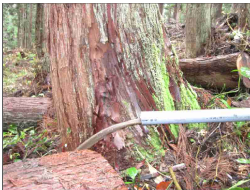
埋設した塩ビ管からの排水処理
