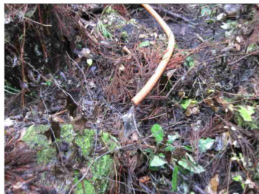
埋設したジャバラホースからの排水処理
