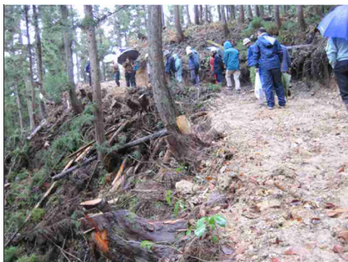
作業路 伐根再利用
