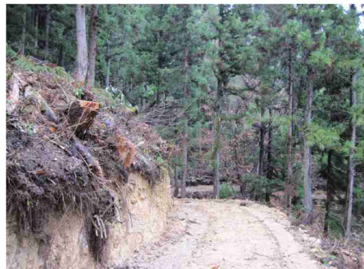
作業路 直切り
