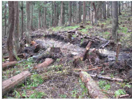
作業道 塩ビ管やジャバラホースを埋設
