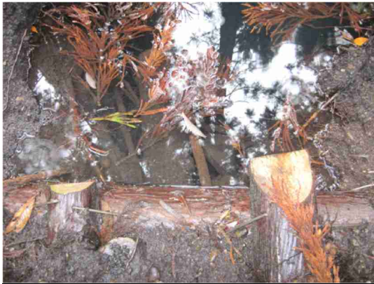
木製集水柵を設置
