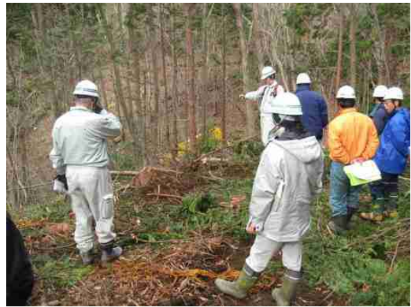
路肩補強の状況説明
