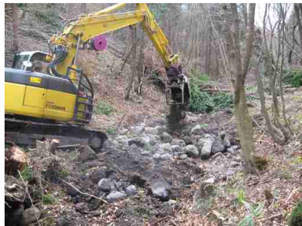
高性能林業機械による洗い越しの作設実演
