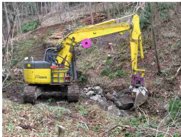
高性能林業機械による洗い越しの作設実演
