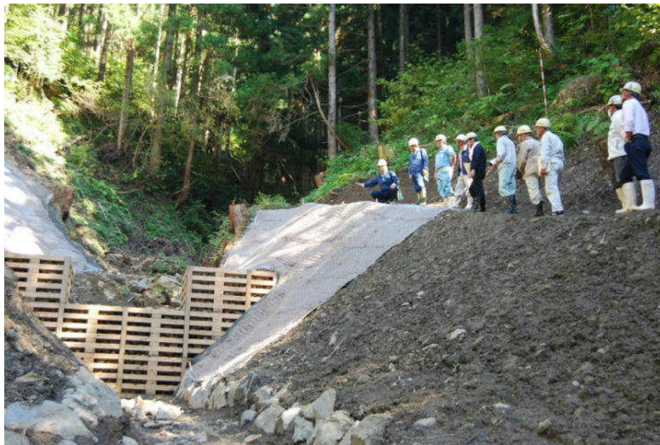
「10月23日 五泉市蛭野地区住民を対象とした治山見学会」
