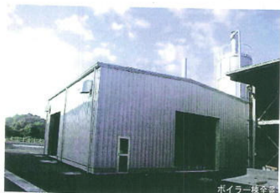
ボイラー棟全景
