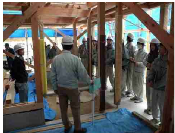
○ 国産材使用の軸組建築現場
