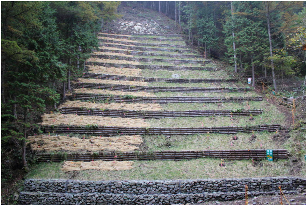
施工後の状況 (写真の左側が宮脇方式による植栽、中央はマット伏工、右側が通常の植栽)
