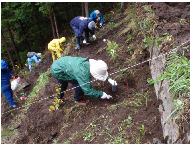
施工後の状況 (写真の左側が宮脇方式による植栽、中央はマット伏工、右側が通常の植栽)
