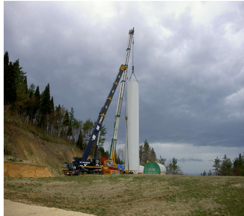
風車タワー据付
