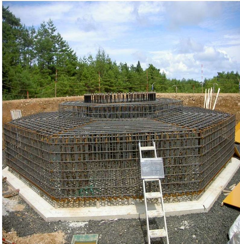
鉄筋組立完了
