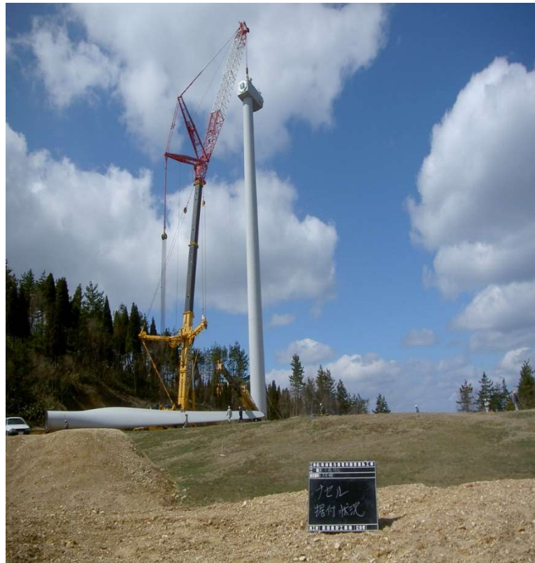
風車ナセル据付
