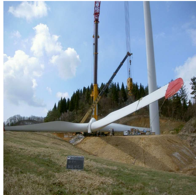
風車ローター組立
