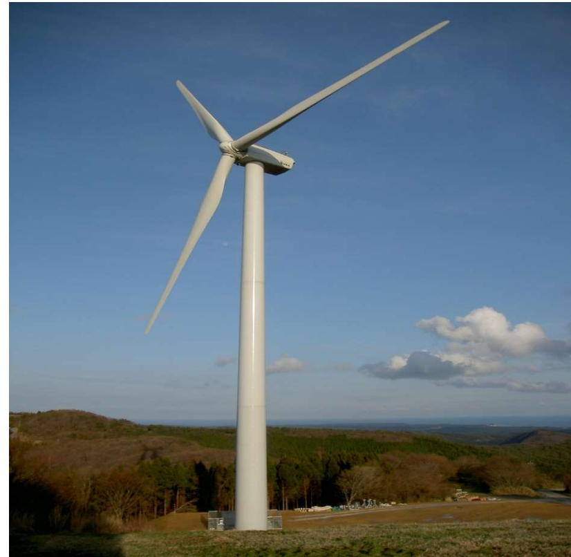
風車据付完了
