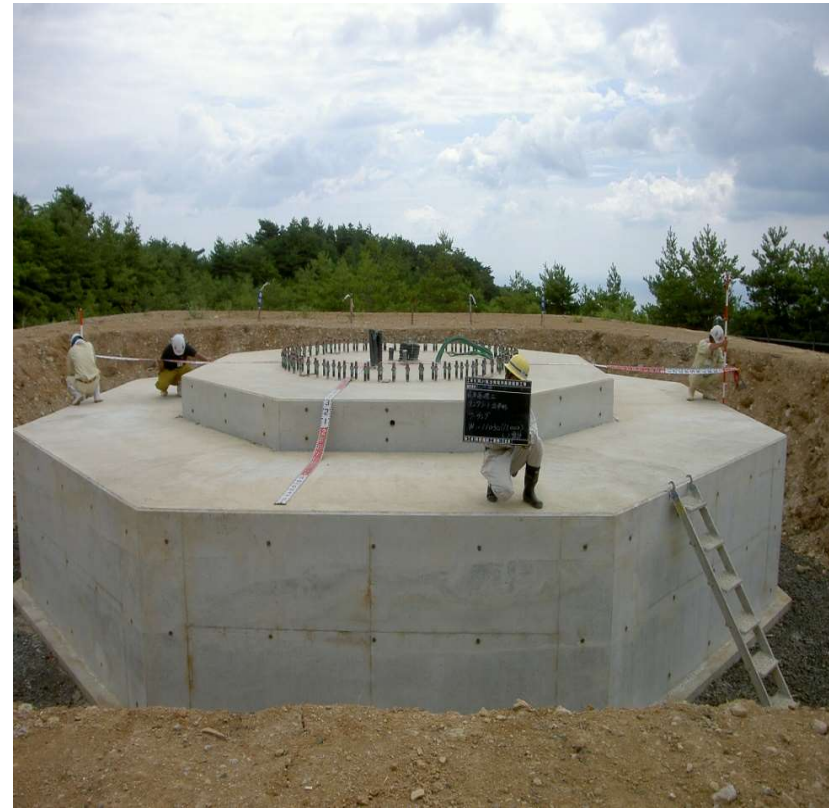
型枠解体完了
