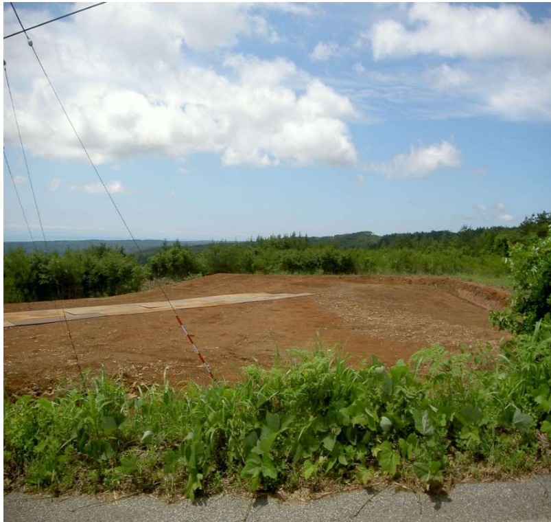
敷地造成完了
