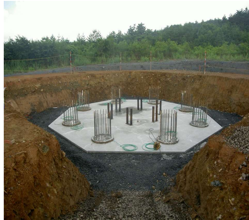
均しコンクリート打設完了
