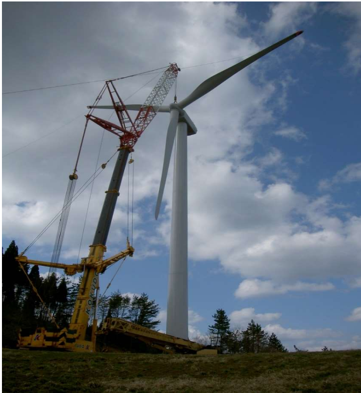
風車ローター据付
