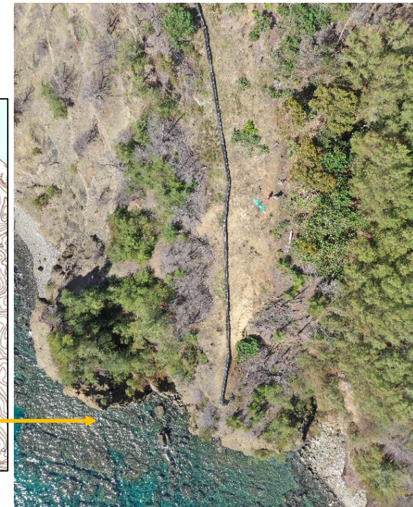
兄島Cライン南端部の状況(R元.10月撮影)
