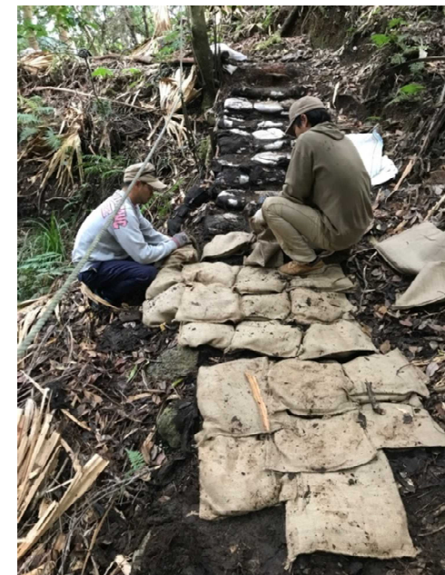
土のうの設置
