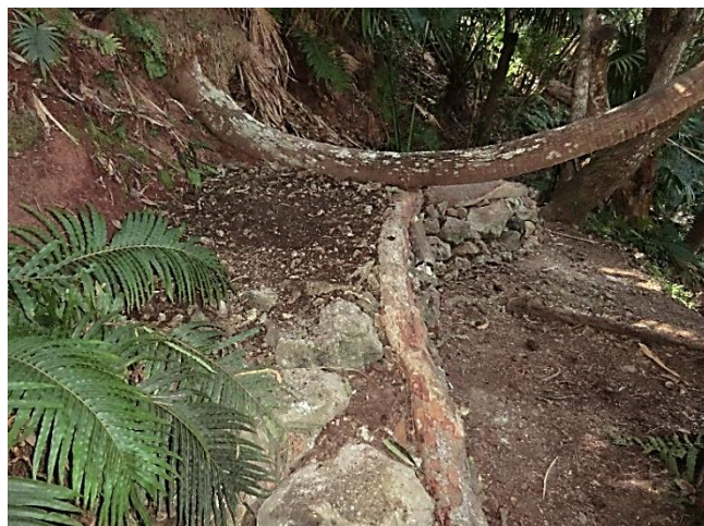
二日かかりでスロープが完成しました。
