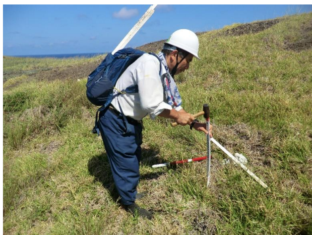
杭を金づちで打ち込み
