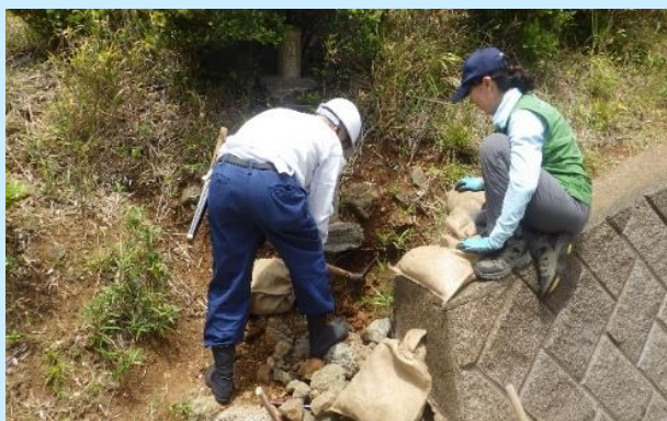
流水で削られた箇所を土嚢と石で応急処置
