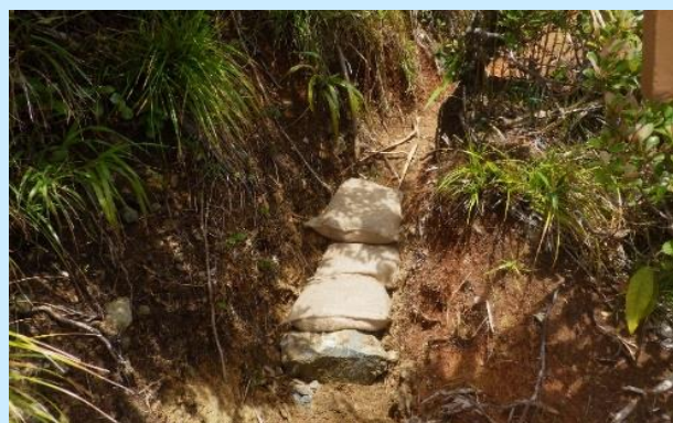
流水で削られた箇所を土嚢と石で応急処置
