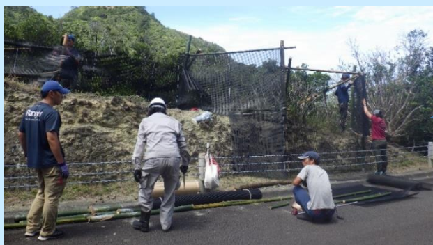
柵設置の様子
