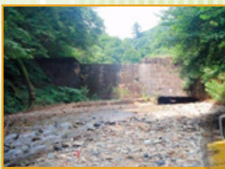
2009年11月に中央部を撤去した「茂倉沢2号治山ダム」
