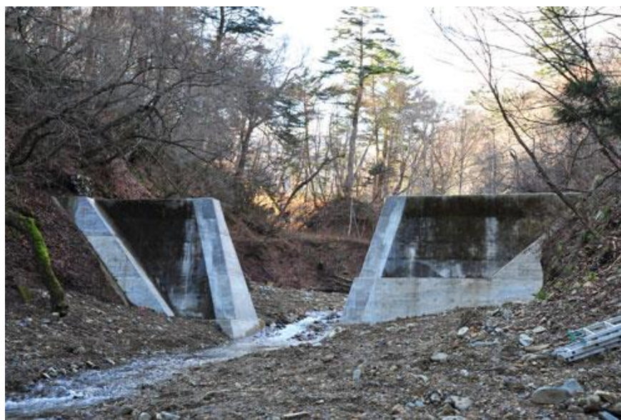
2009年11月に中央部を撤去した「茂倉沢2号治山ダム」
