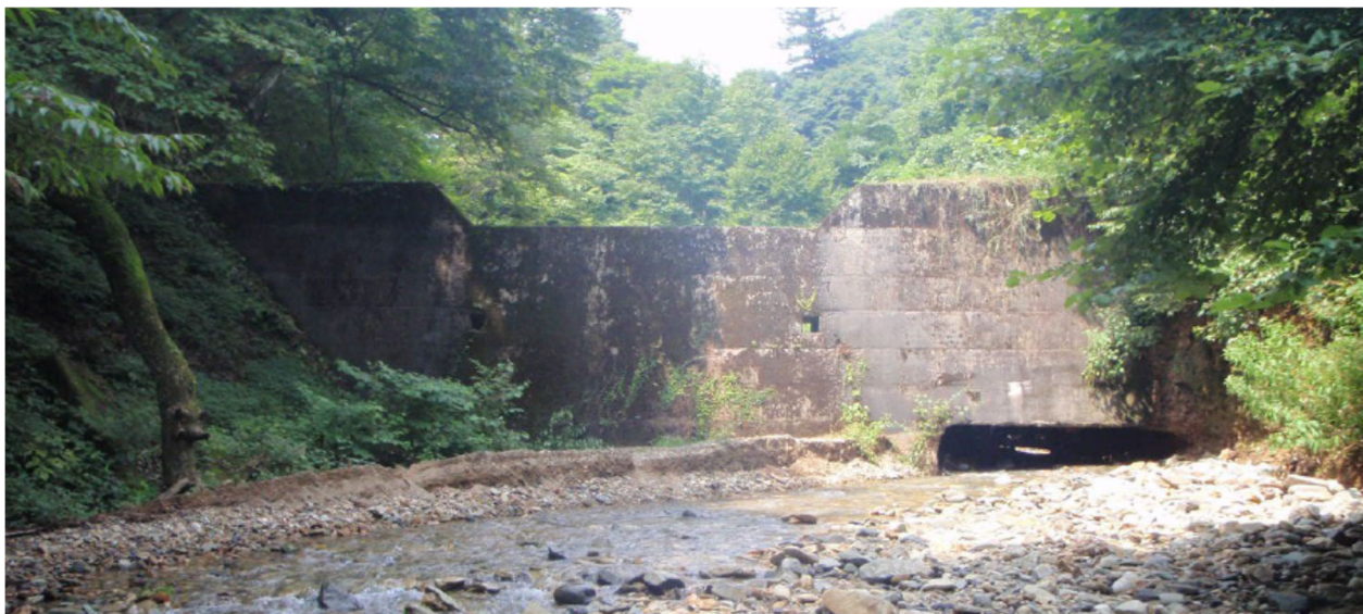
図2. 3-8 中央部撤去前のNo. 2ダム（H25茂倉沢事業概要より転載）
