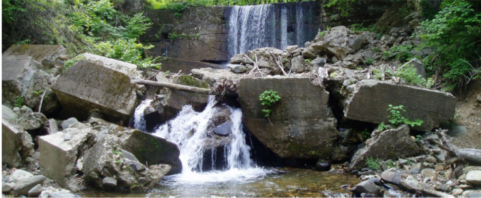
図2. 3-12 NO.4ダムの倒壊状況（奥に見えるのはNo.5ダム） （2005年撮影 H25茂倉沢事業概要より転載）
