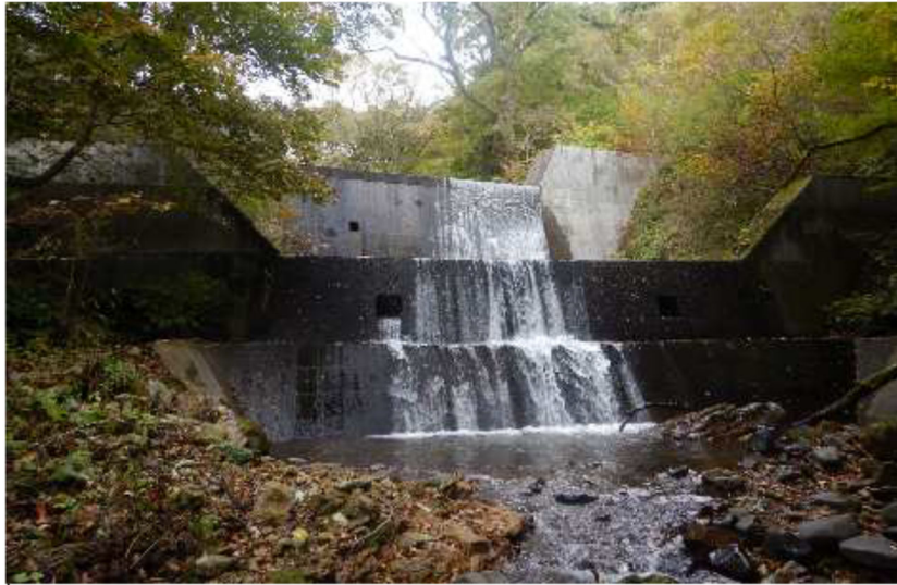
図2. 3-5 改修後のNo.1ダム 令和3年10月29日撮影
