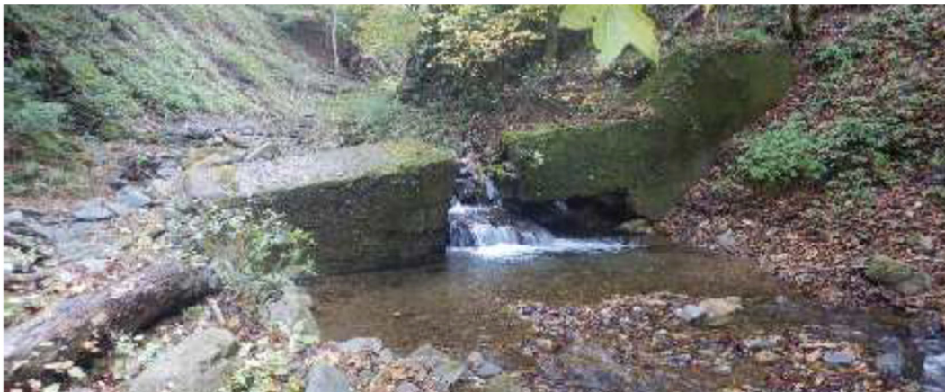
図2. 3-11 No.3ダムの副堤は倒壊し、堤体の一部が残存 （上 2005年撮影 H25茂倉沢事業概要より転載、下 2021年10月29日撮影）
