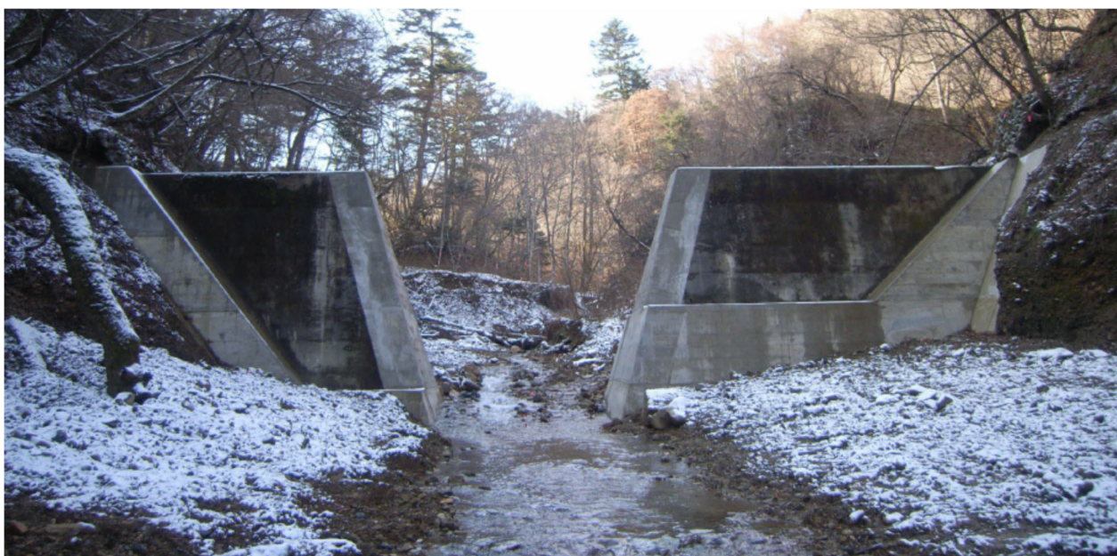
図2. 3-9 中央部撤去後のNo. 2ダム（H25茂倉沢事業概要より転載）
