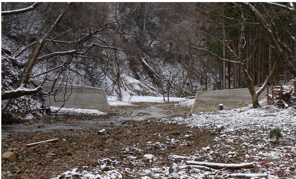
写真 3-2 平成 21 年度に設置した保全工
