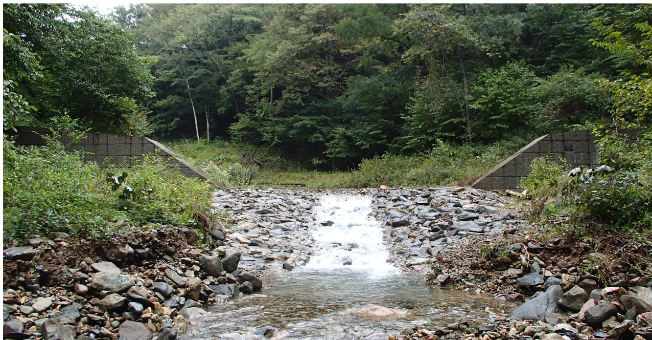
写真 3-3 平成 21 年度に設置した No.5-1 ダム
