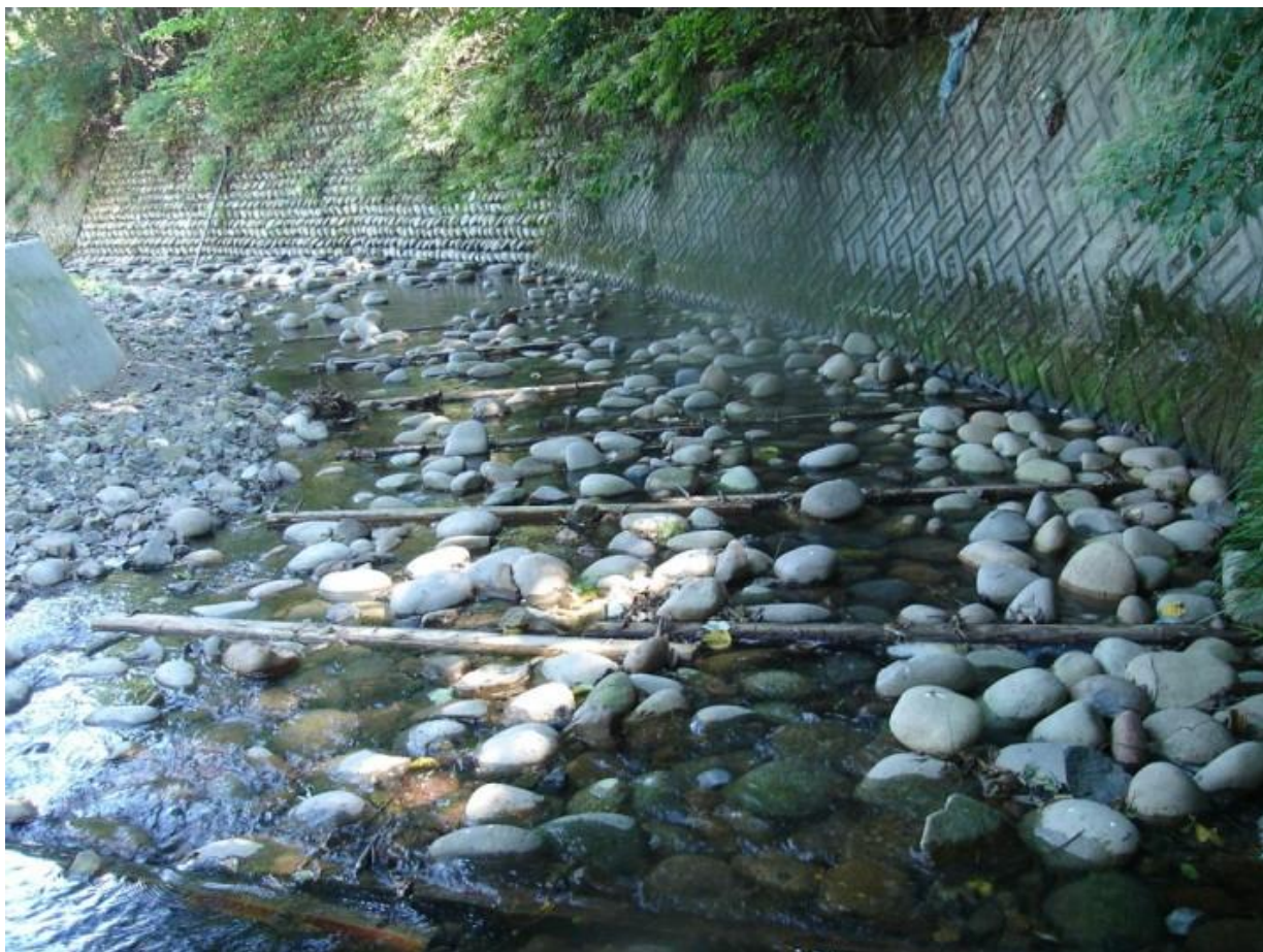
写真 6-3 木工沈床による根固工の施工例：岐阜県岩手川
