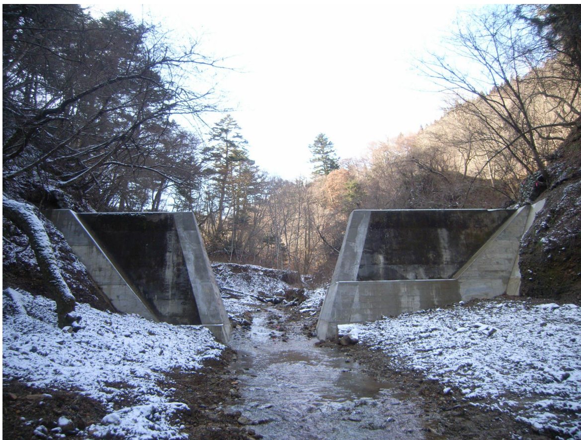
写真 3-1 平成 21 年度に中央部を撤去した No.2 ダム
