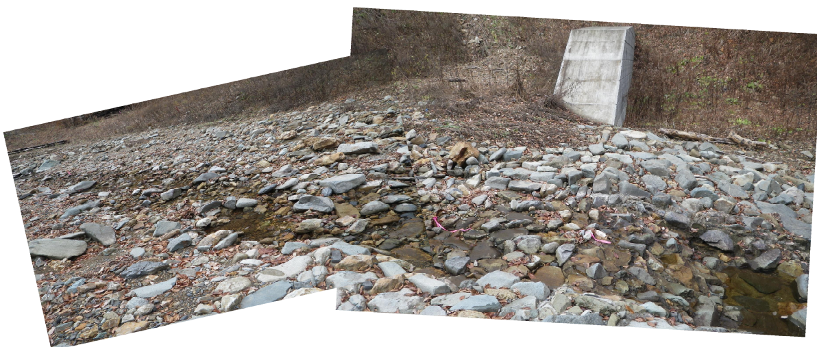
写真 6-2 No.5-1 ダム～No.5-2 ダム間の瀨切れ状況 (平成 25 年 12 月 5 日撮影)
