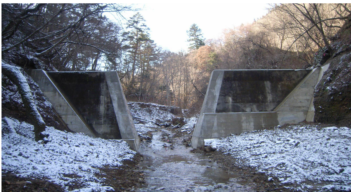
写真 1-2 中央部撤去後の茂倉沢 No.2 ダム
