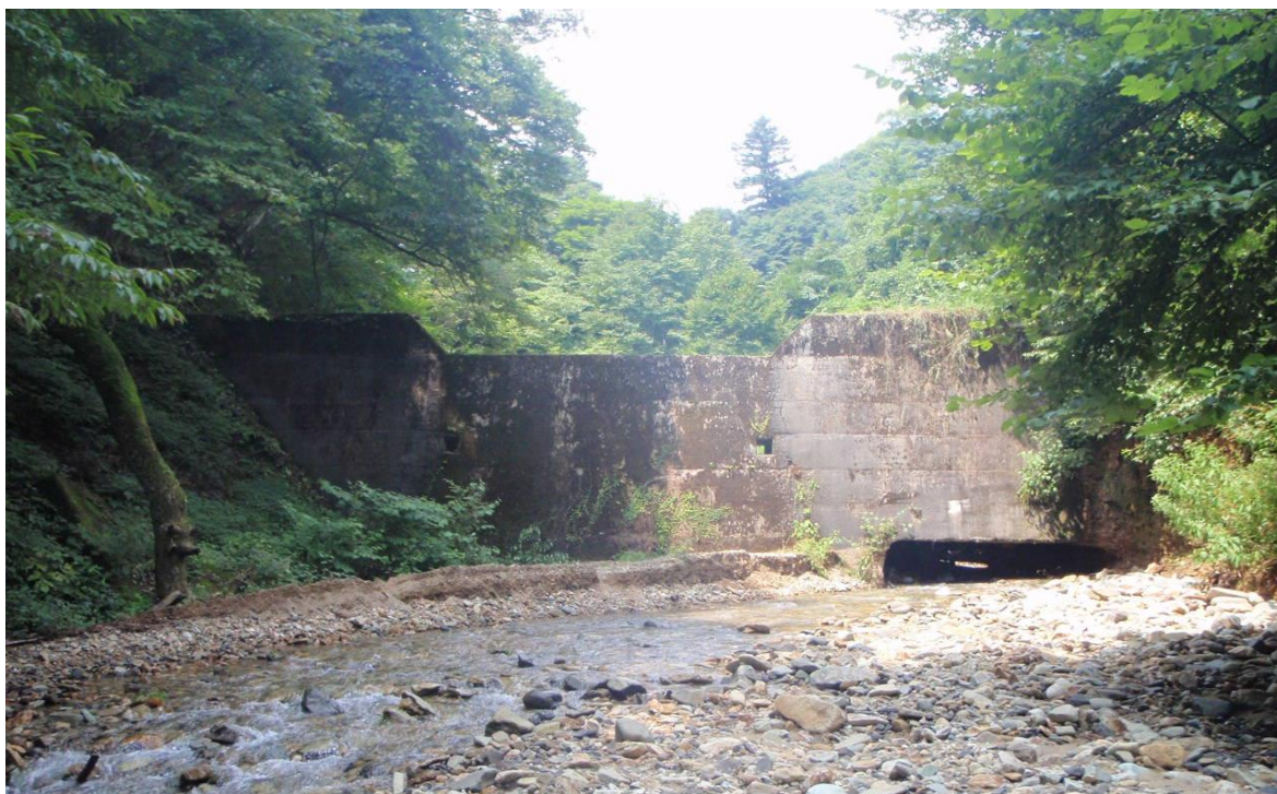
写真 1-1 中央部撤去前の茂倉沢 No.2 ダム
