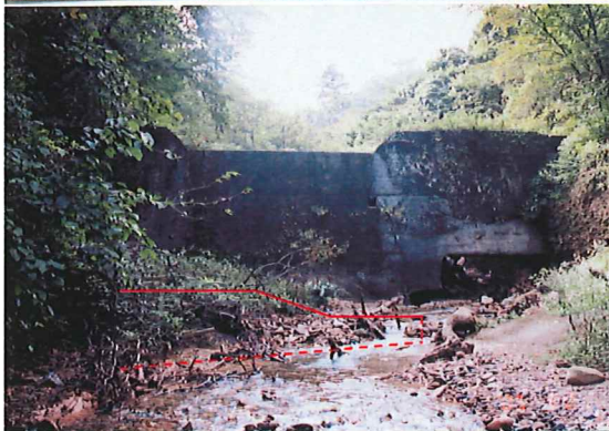
写真一38 撤去を計画した被災ダム (No2 ダム)
