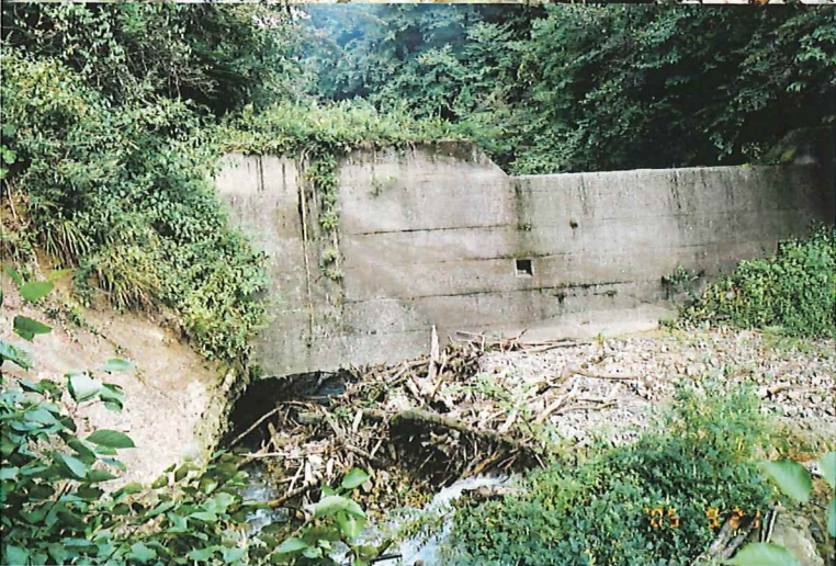
写真一15 No2 ダム（本堤）上流側
