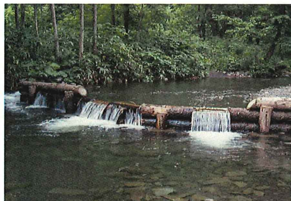
写真—39 魚類等の生息環境改善のために試験的に設置された木製構造物
