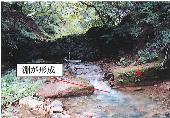
写真一37 横断構造物により形成された淵
