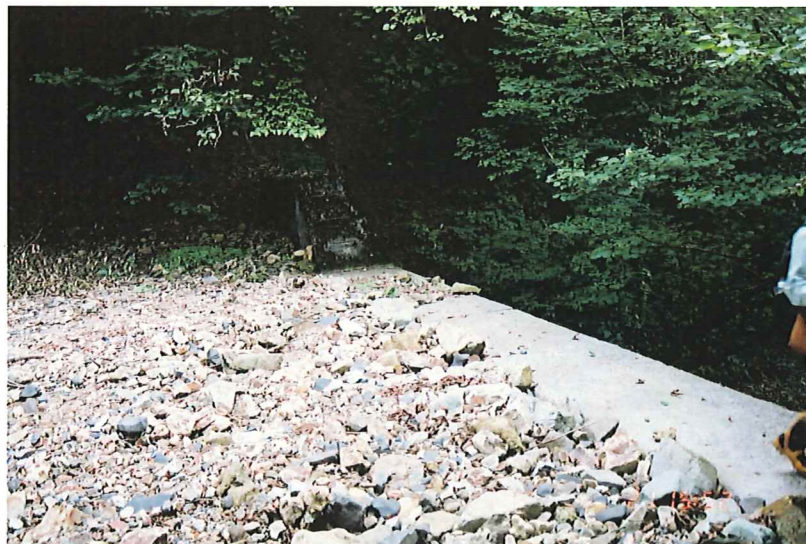
写真一34 No 8 ダムの堆砂敷 常水はみられない。
