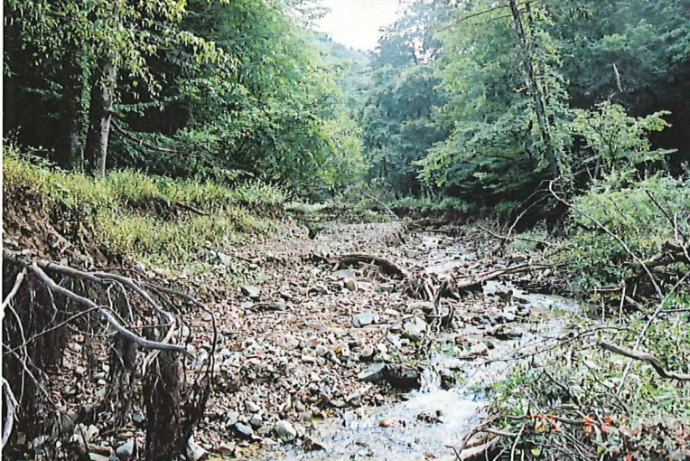
写真一17 No2 ダムの上流 侵食が進んでいる。
