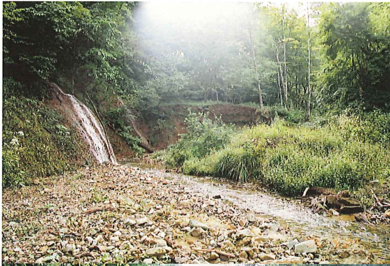
写真一16 No2 ダムの堆砂敷 堆砂敷が侵食を受けた。
