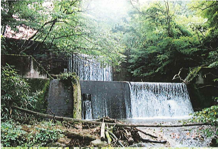
写真一10 No1 ダム（前提・本堤）
