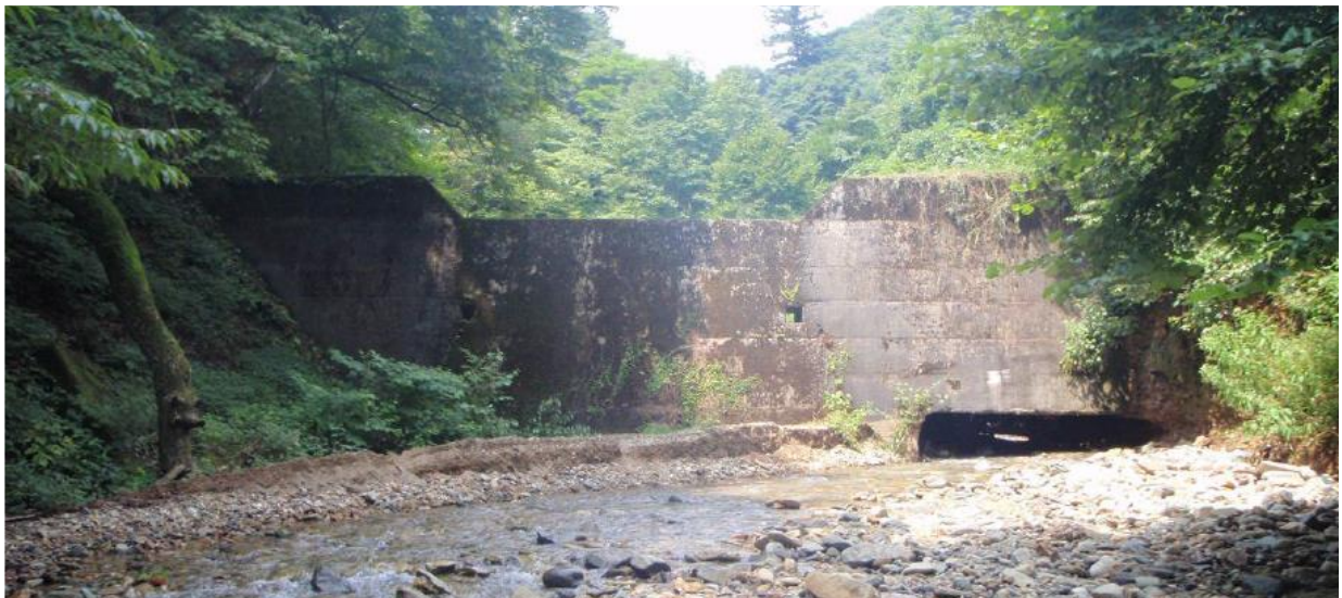
中央部撤去前の No2ダム。写真右下が底抜け部分
