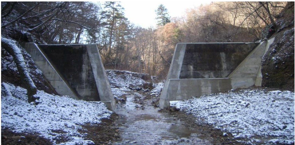
中央部撤去後の No2ダム。底抜け部分
