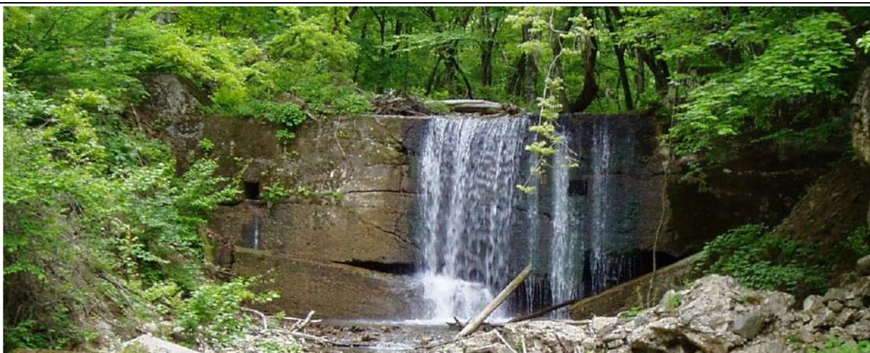
No. 5ダムの損傷状況
