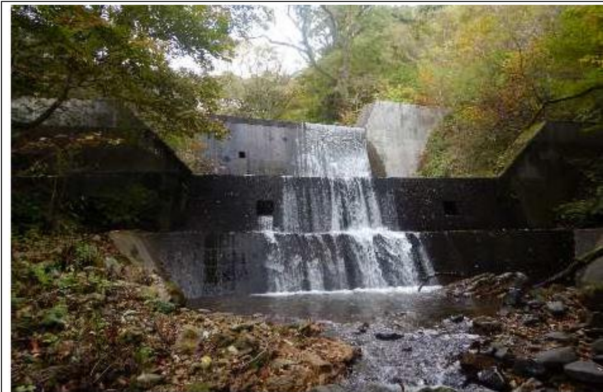
増厚・嵩上後のNo1ダム
