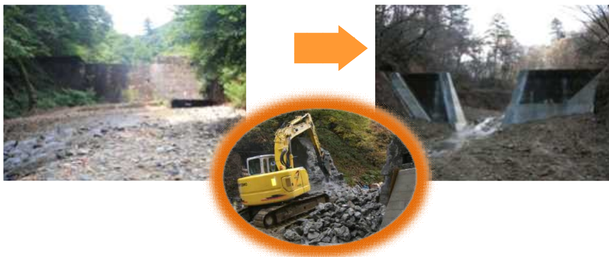
2009年11月に中央部を撤去した「茂倉沢2号治山ダム」
