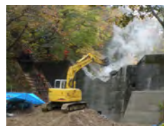
・治山ダムによる連続性の分断
