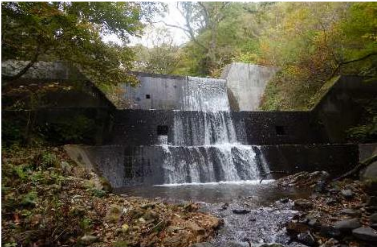
増厚・嵩上後のNo1ダム
