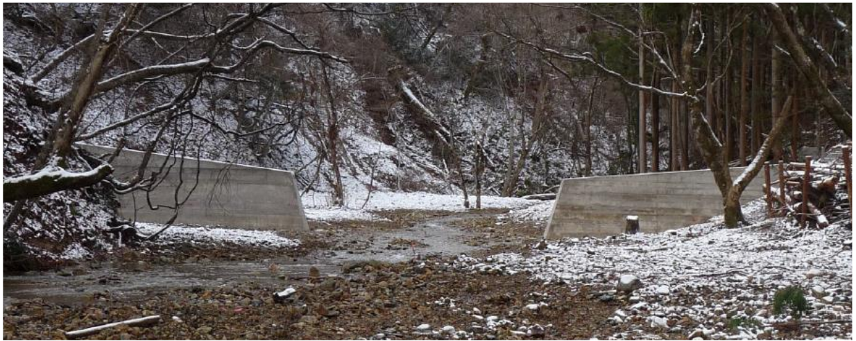
No2ダム下流に新設した保全工
