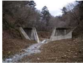
平成 21 年 11 月に中央部を撤去した「茂倉沢 2 号治山ダム」
