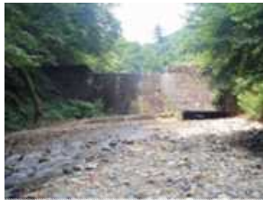
平成 21 年 11 月に中央部を撤去した「茂倉沢 2 号治山ダム」
