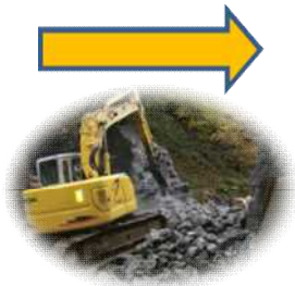
平成 21 年 11 月に中央部を撤去した「茂倉沢 2 号治山ダム」
