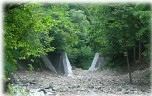
中央部を撤去した2号ダム(左)とその200m下流に設置された保全工(右)
