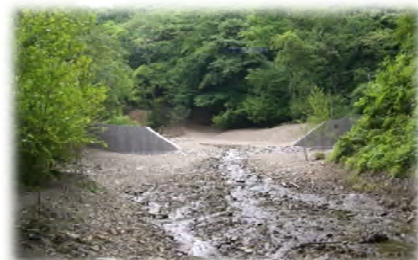
5号ダムの底抜けによる不安定土砂の移動抑止のために設置された5-1号ダム
