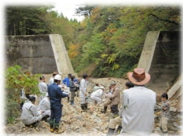
全国ではじめて、治山ダムの改修工事により、中央部が開放された「茂倉沢2号ダム」を説明
