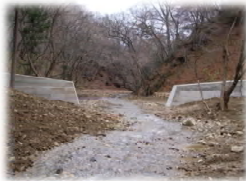
中央部を撤去した2号ダム(左)とその200m下流に設置された保全工(右)
