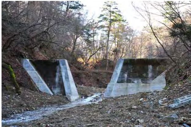
図10 2009年11月に中央部を撤去した茂倉沢2号治山ダム
