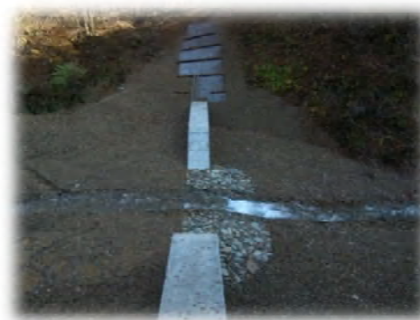
5号ダムの底抜けによる不安定土砂の移動抑止のために設置された5-1号ダム
