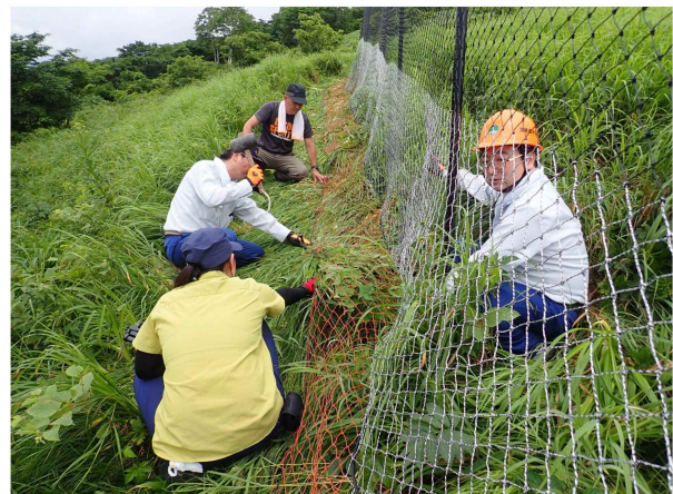
アンカーの打込作業
