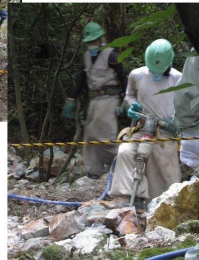
落石の破碎作業
