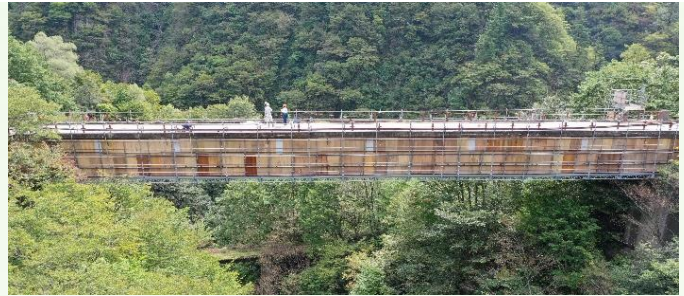
師走沢橋の施工状況
