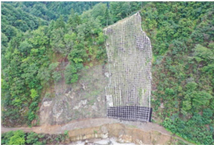
山腹工（R5年度施工）
