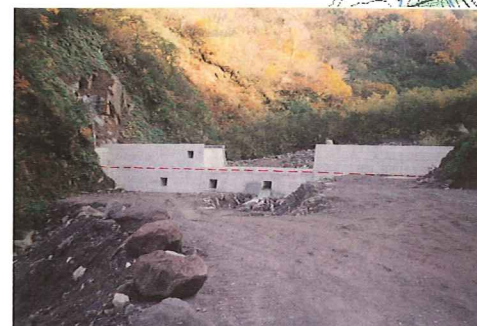
第13号コンクリート谷止工
