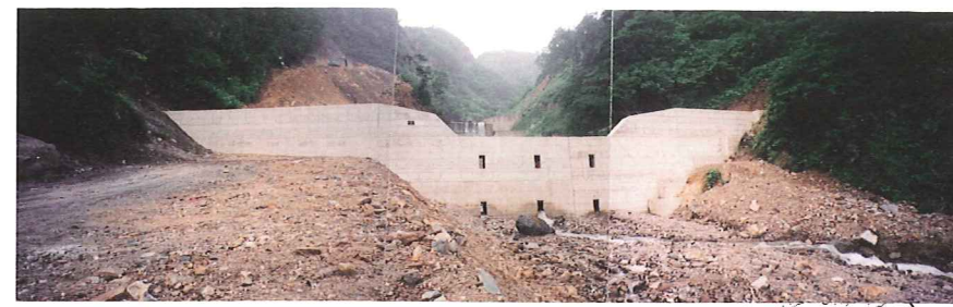
第7号コンクリート谷止工
