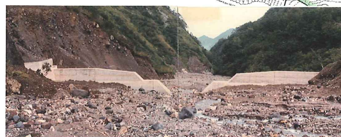
第5号コンクリート堰堤工
