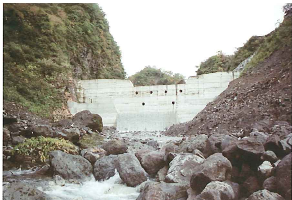
火打山川 第14号コンクリート谷止工
