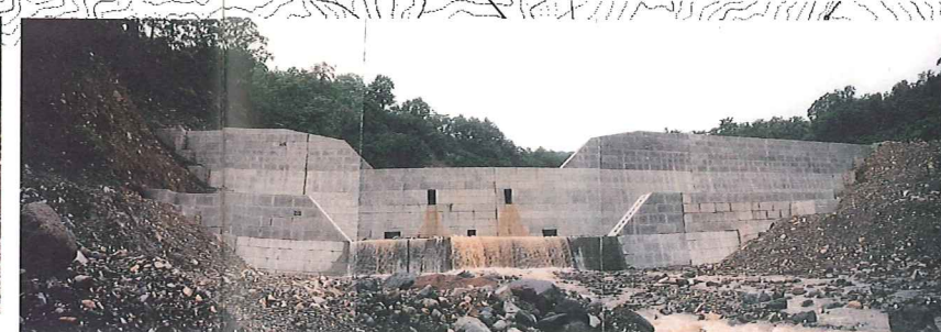
第2号コンクリート谷止工
