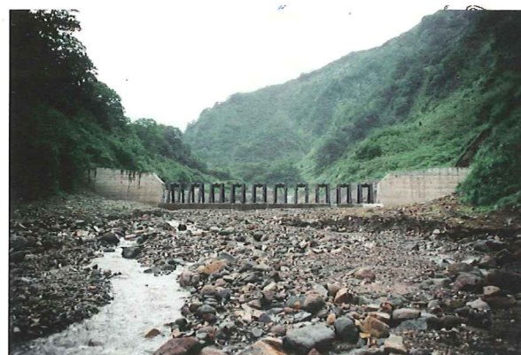
第1号鋼製スリットダム
