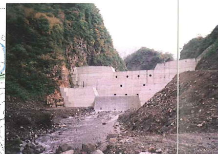
第14号コンクリート谷止工
