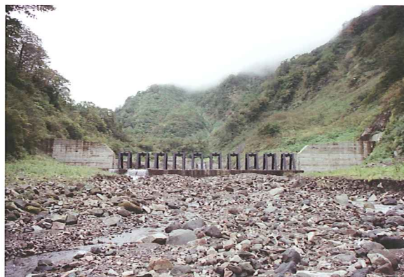
焼山川 第1号鋼製スリットダム
