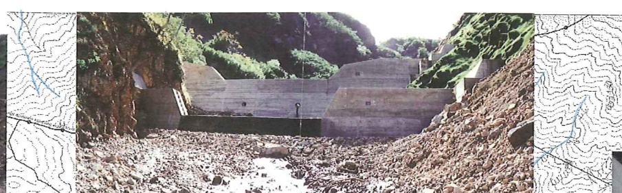
第7-1号コンクリート堰堤工
