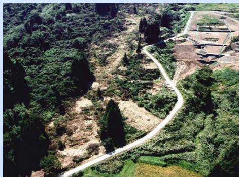
▲災害発生時（H15.6撮影）
