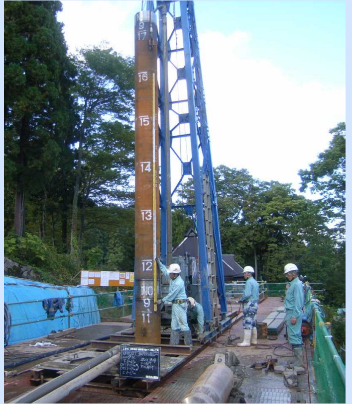
鋼管杭工
