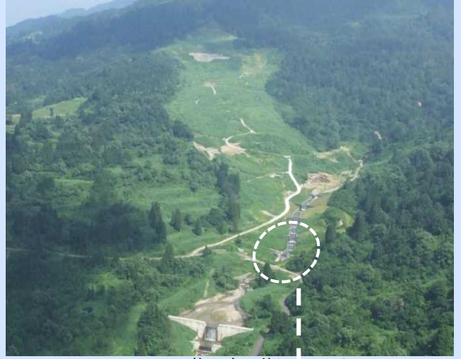
▲施工完了状況(H18.7)
