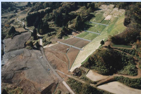
▲施工完了状況（H13.10）
