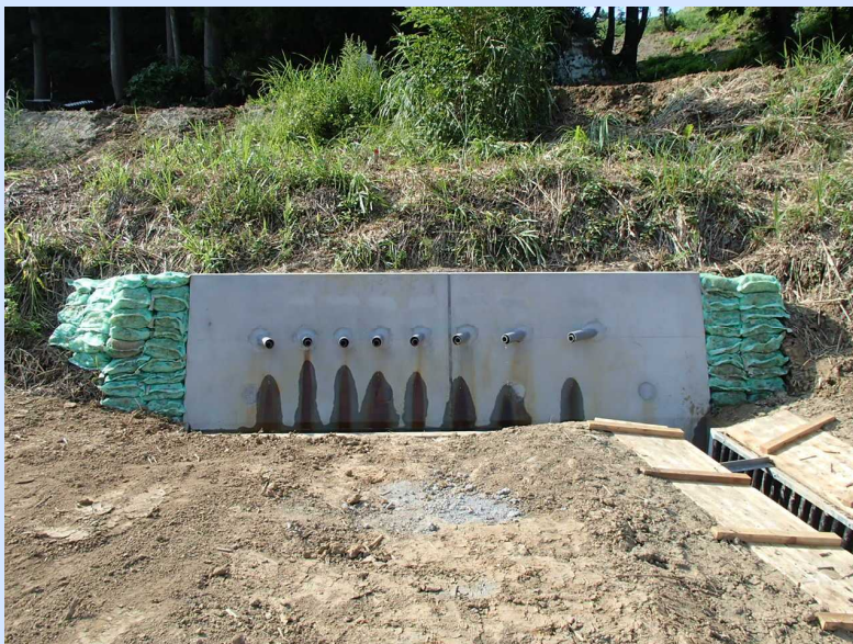
横孔ボーリング排水工（保護壁設置）
