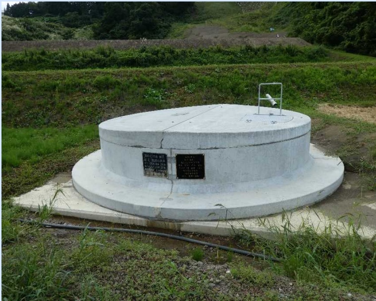
ライプレート集水井工（コンクリート蓋）
