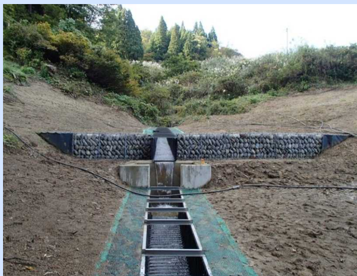
大型フトン籠土留工
