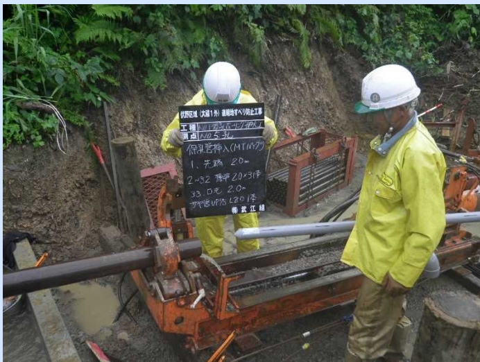
MTパイプの挿入
