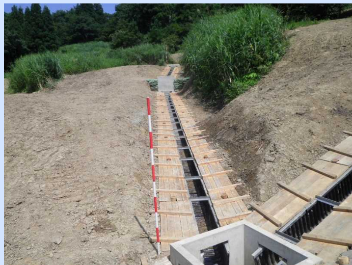
角型U字溝水路工（木製水路保護板設置）
