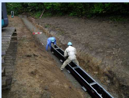
角型U字溝水路工（木製水路保護板設置）
