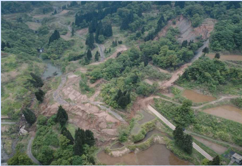
▲災害発生時状況（H12.5）
