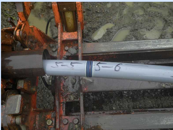
MTパイプの挿入（パッカーゴム部分）
