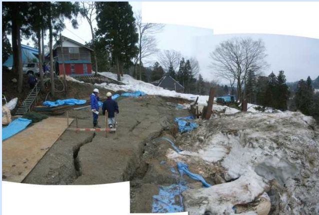
▲災害発生時（H22.4発生）
