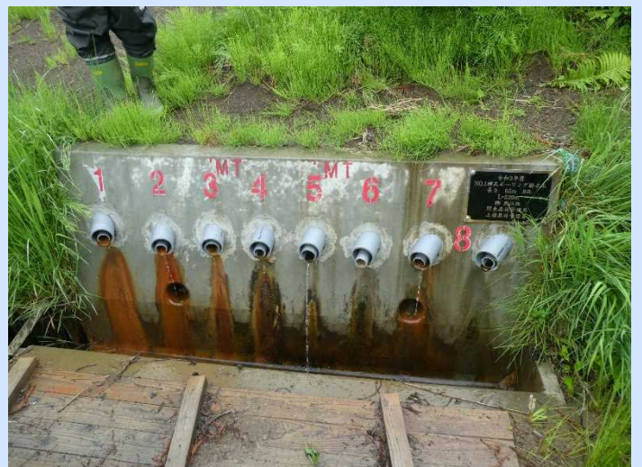
No.5のMTパイプの集水量が一番多い約1ℓ/min
