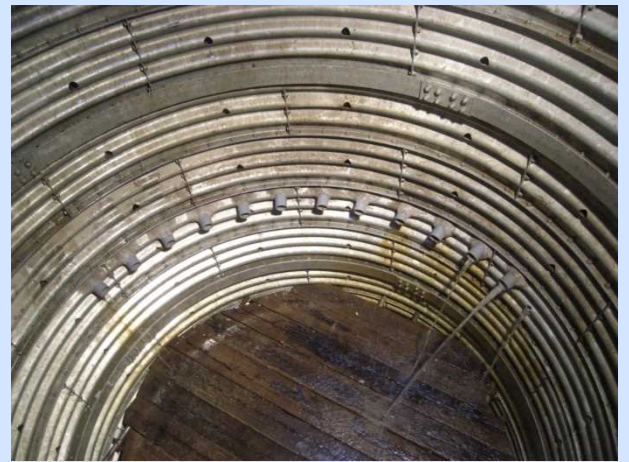
集水ボーリングの集水状況
