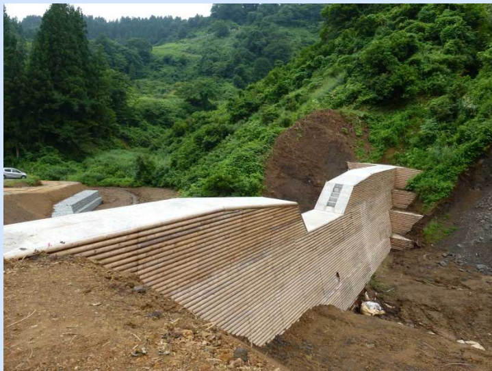
コンクリート谷止工（木製残存型枠）
