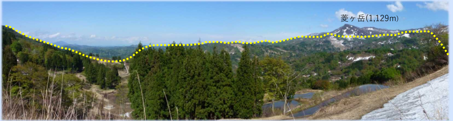
伏野地すべり防止区域（上越市安塚区）
