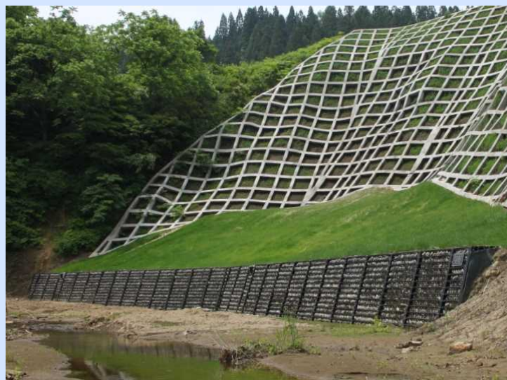
鋼製枠土留工
