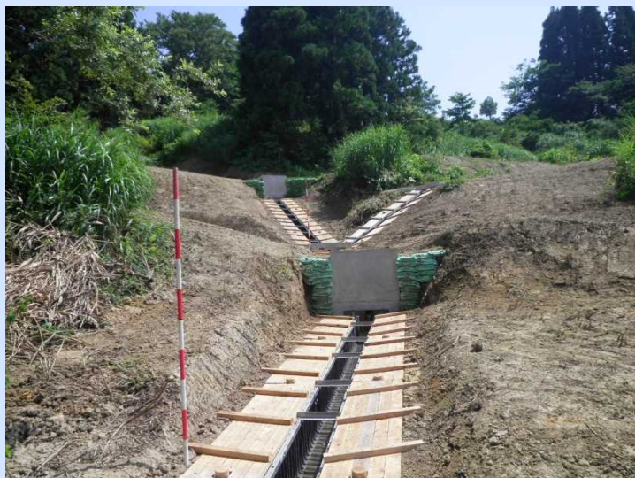
角型U字溝水路工（木製水路保護板設置）
