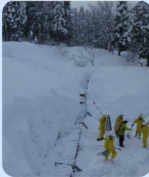
作業現場（安塚区上山R2.12）
