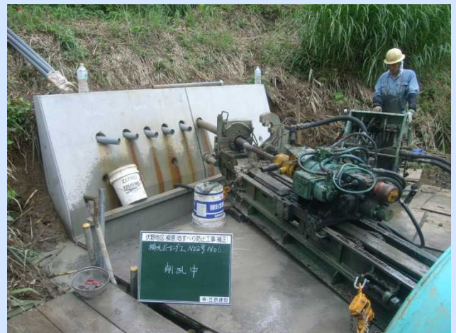
削孔（ボーリング）状況
