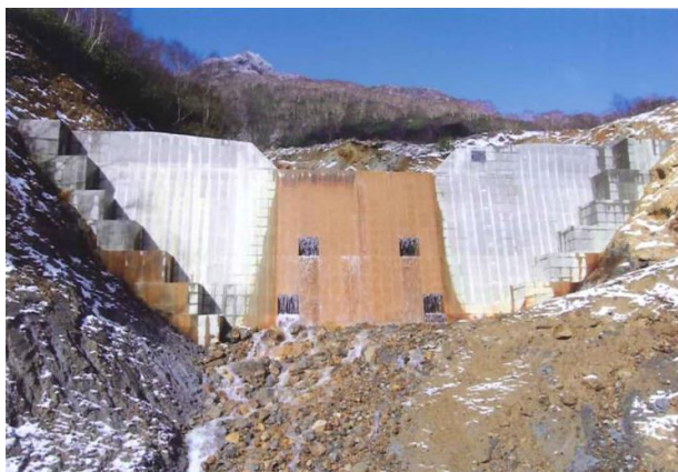
【No. 15コンクリートダムの新設】
