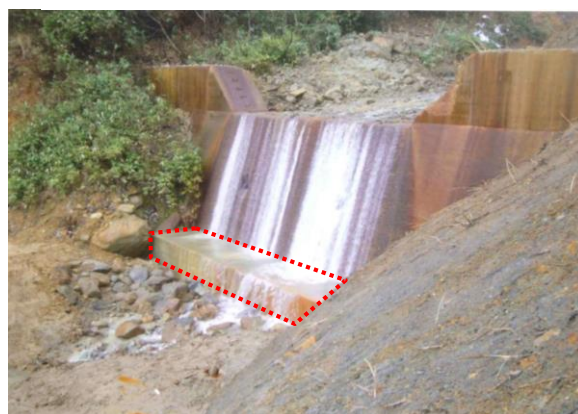
【No. 7コンクリートダムの根固め】
