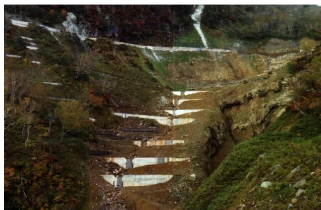
【コンクリート土留工】
