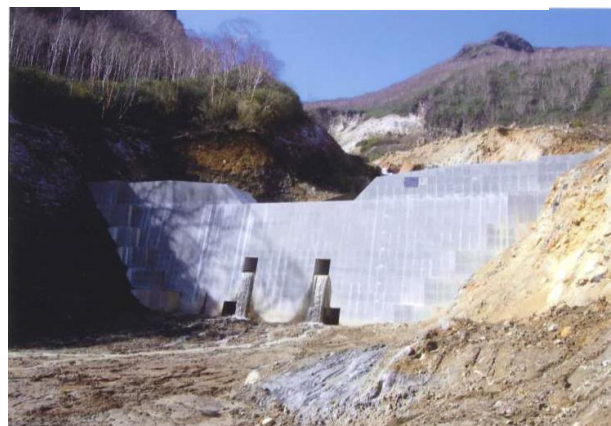
【No. 16コンクリートダムの新設】
