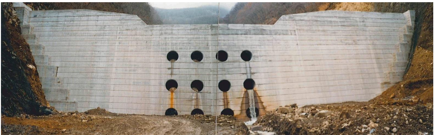
No. 4-1 コンクリートダム
