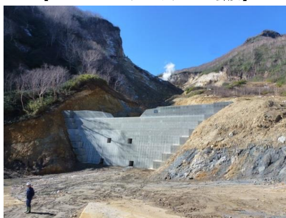
【No. 17コンクリートダムの新設】
