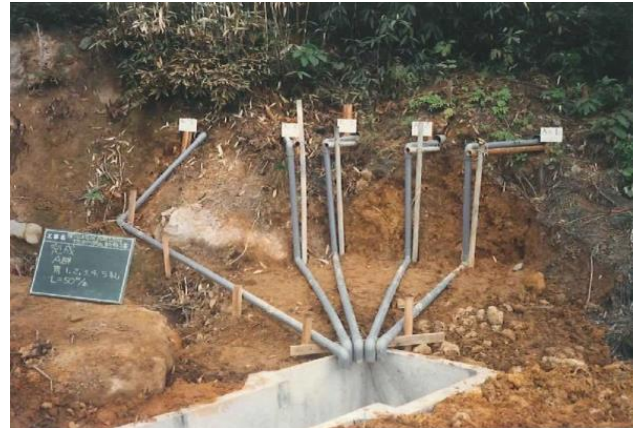
【横孔ボーリング排水工】
