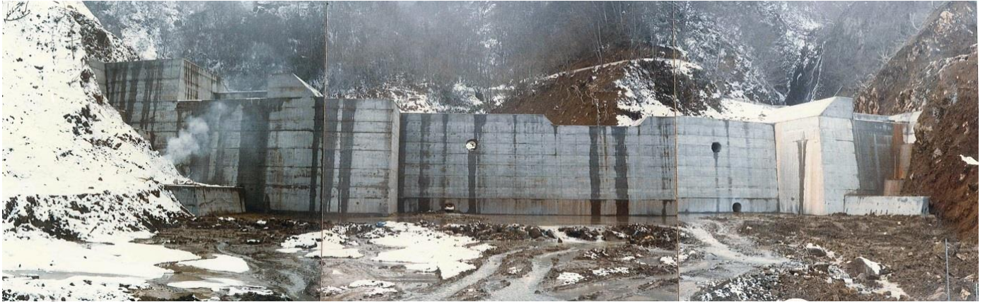
No. 3 コンクリートダム
