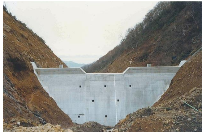
No. 5 コンクリートダム
