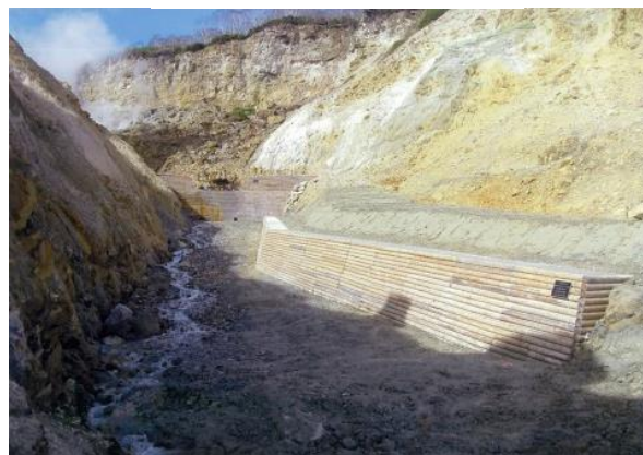
【コンクリート護岸工】
