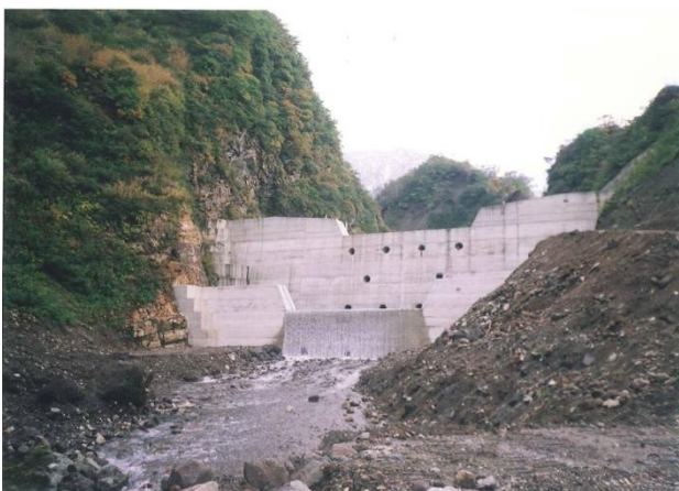
【No. 7 コンクリートダム及び副堤】
