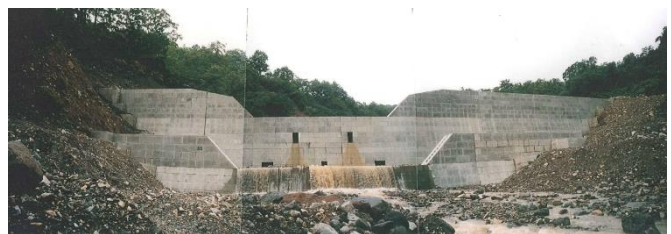
【No. 2 コンクリートダム及び副堤】
