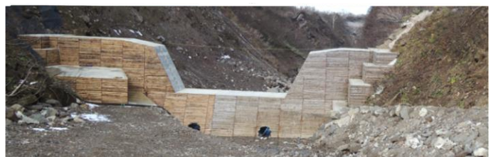
【No. 18 コンクリートダム】
