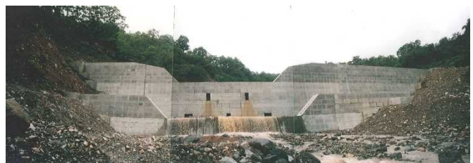
【No. 2 コンクリートダム及び副堤】
