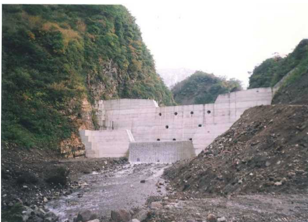
【No. 7 コンクリートダム及び副堤】
