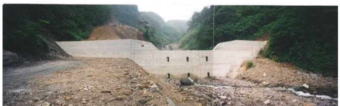
【No. 14 コンクリートダム】
