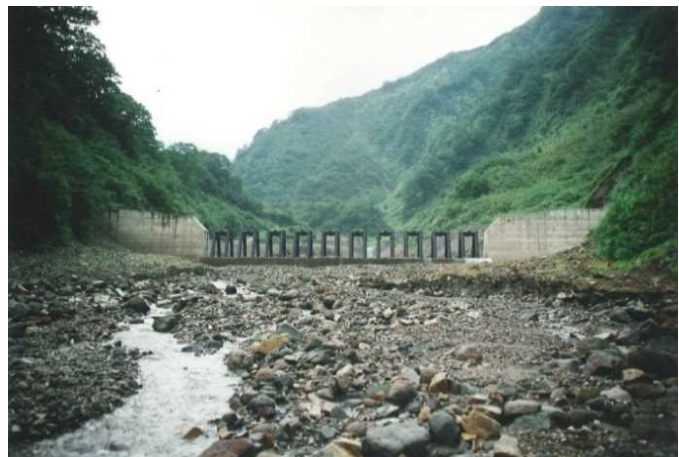
【No. 1 鋼製スリットダム】
