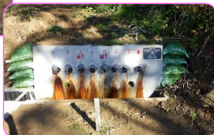
横孔ボーリング排水工
