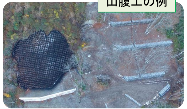
コンクリート法砕工と土留工
