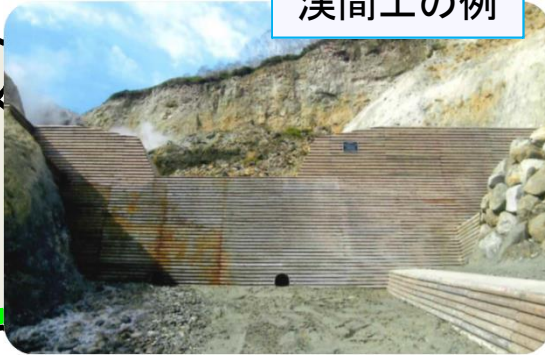
丸太残存型砕を用いた谷止工
