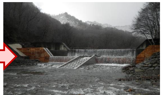
完成した谷止工(副ダム)
