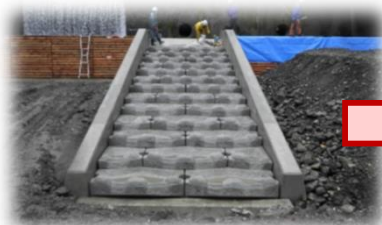
魚類の遡上も考慮し、中央部に魚道を設ける施工
