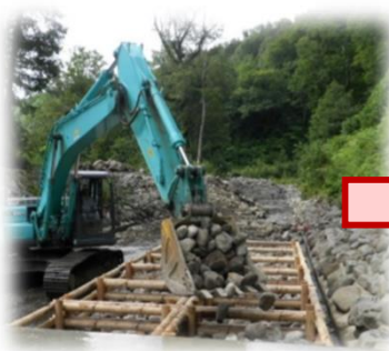
木材を利用した木工沈床工
