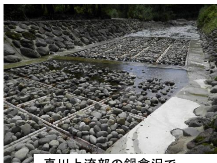
真川上流部の鍋倉沢で平成26年より施工されている流路工 令和3年度で完成
