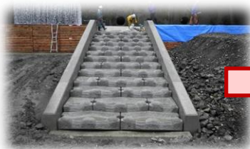
魚類の遡上も考慮し、中央部に魚道を設ける施工
