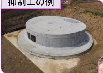
ライナープレート集水井工
