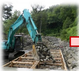
木材を利用した木工沈床工
