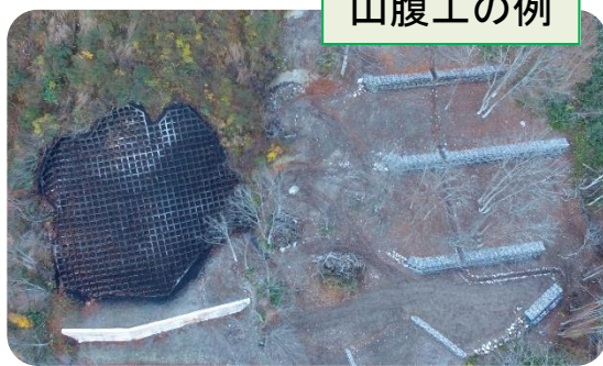
コンクリート法枠工と土留工
