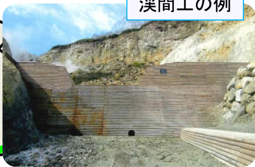
丸太残存型枠を用いた谷止工
