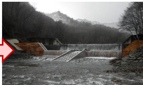
完成した谷止工（副ダム）
