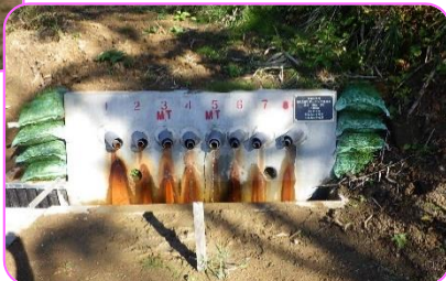
横孔ボーリング排水工 —5—
