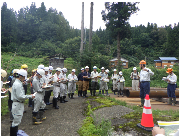
①工事概要の説明
