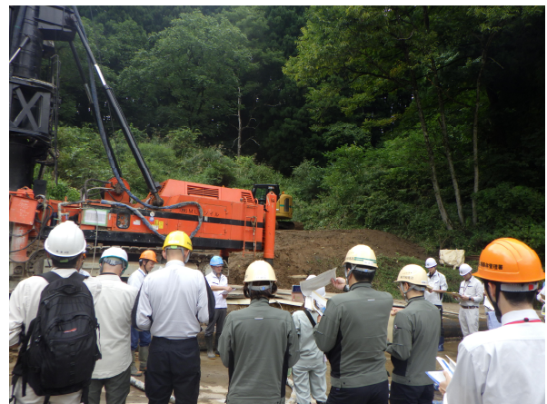
②杭工の視察状況
