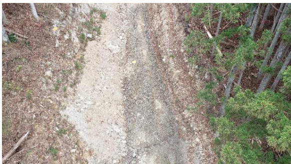
No.4 谷止工施工前（令和7年度）
