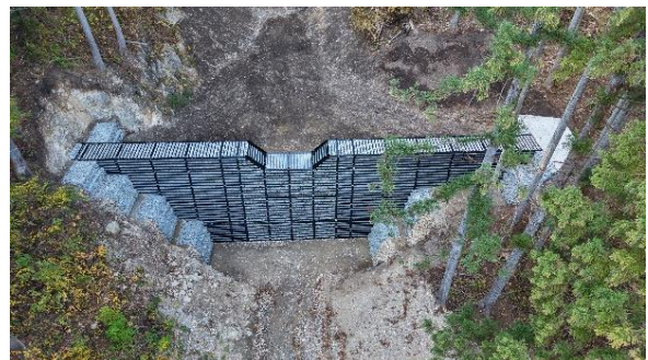
No.4 谷止工施工後（令和7年度）
