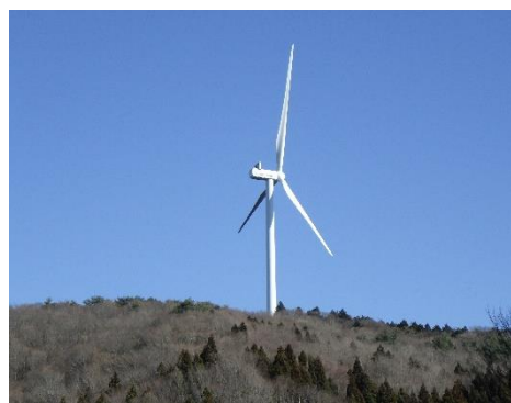
風車発電施設
