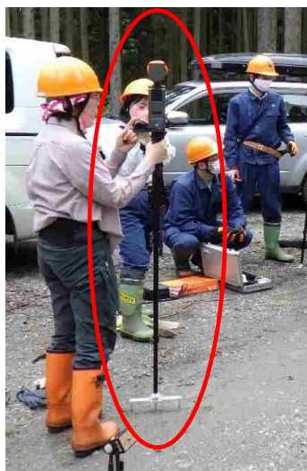
赤枠は、組み立てたICT機器（地上型3Dレーザ照射スキャナ）
