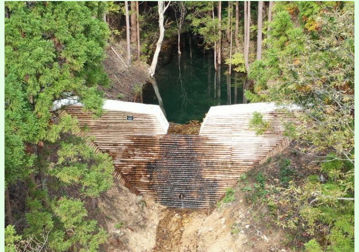
丸太残存型枠を用いた谷止工
