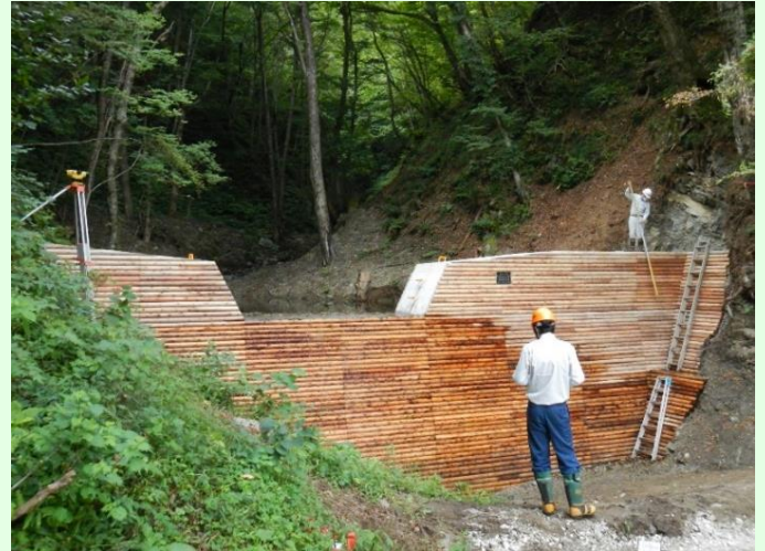
丸太残存型桎を用いた谷止工
