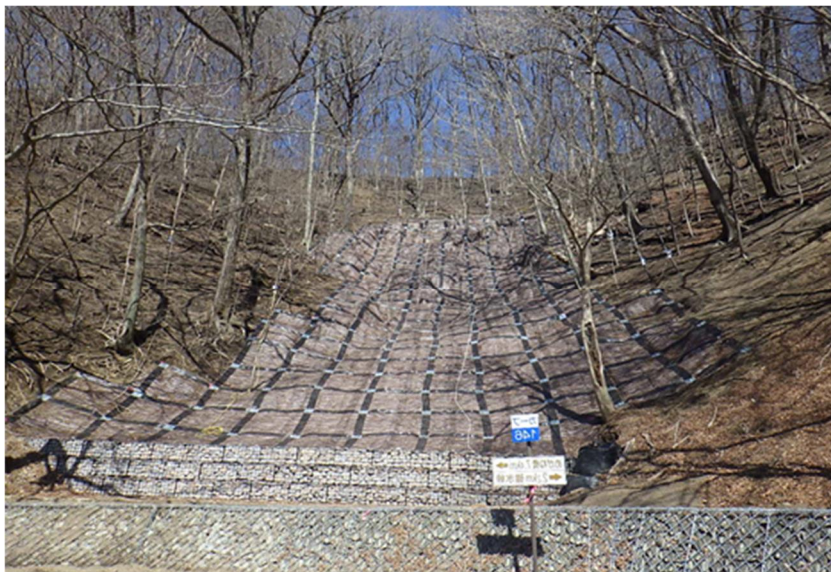
○山腹工（帯状法面工） 1042.3 m 2 ○鋼製かご柵 58m
