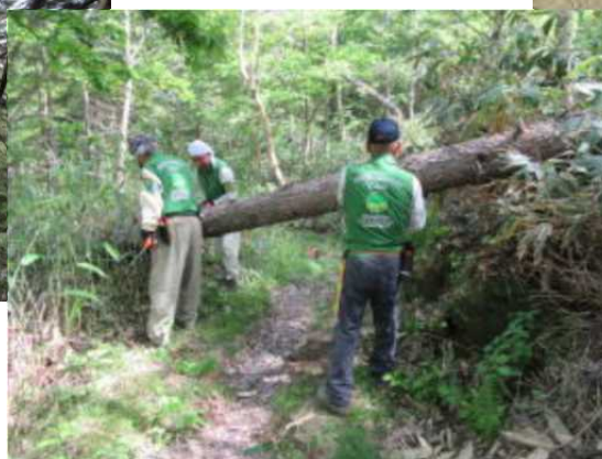
歩道の障害物を除去（吾妻署：草津町）
