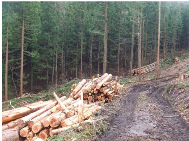
森林作業道の作設（群馬署：高崎市）
