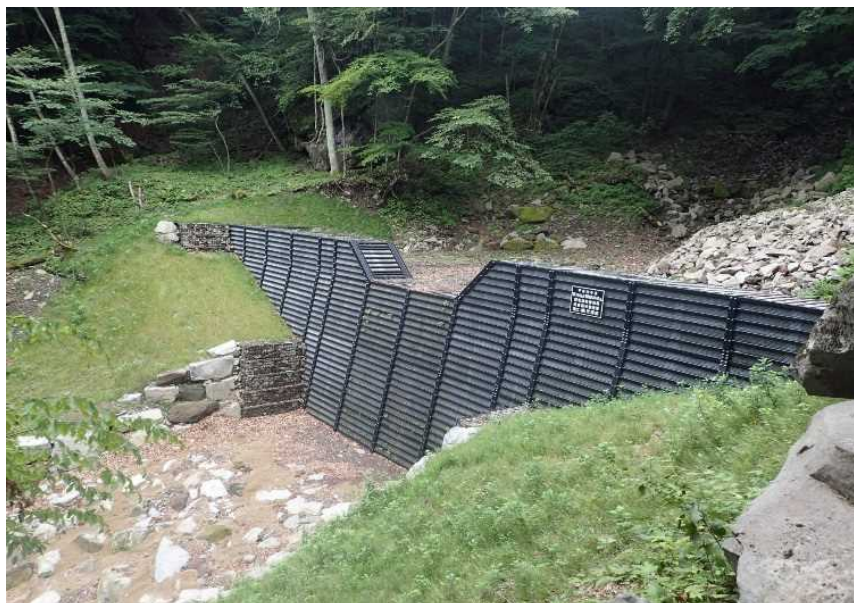
鋼製枠谷止工（吾妻署：長野原町）
