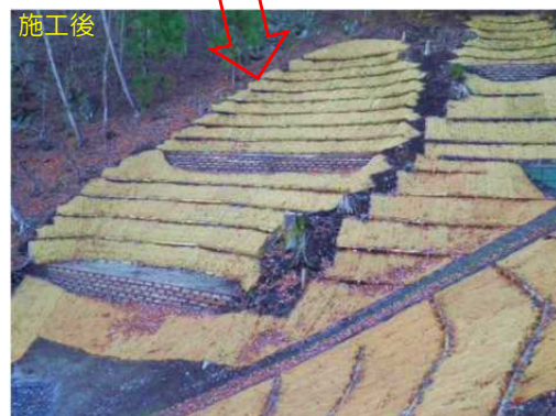
間伐材を利用した丸太積土留工（利根沼田署：沼田市）
