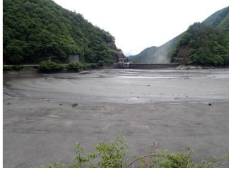
堆砂率が上昇した発電ダム
