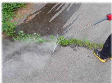
刈払機の刃を傷めるような箇所での作業状況（飛び石等の防護対策も不要）
