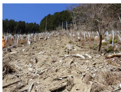
写真3 被害調査時全景
